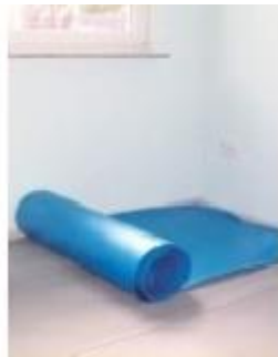
Trittschalldämmung ausrollen
